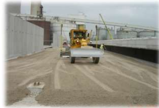
Centrale de Provence
