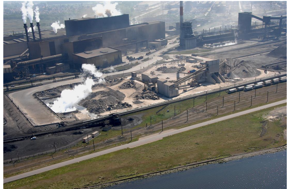
Implantation de SGA sur le site d'ArcelorMittal Dunkerque
