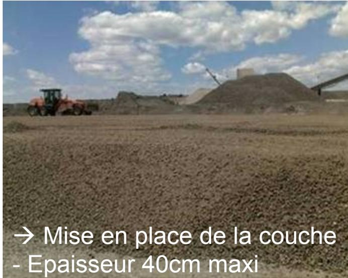
Afin de réduire les effets de l'expansion du laitier d'aciérie, maturation par arrosage et par brassage :
