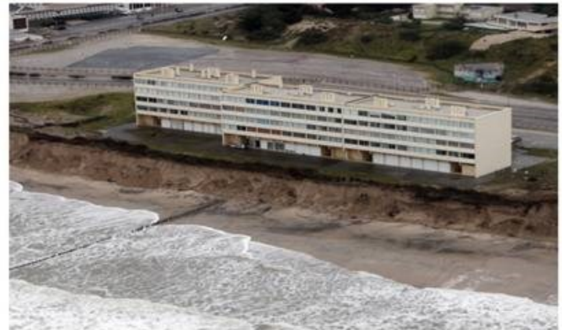
▲ À Soulac, l'immeuble Le Signal est en sursis. © PHOTO THEILLET LAURENT
