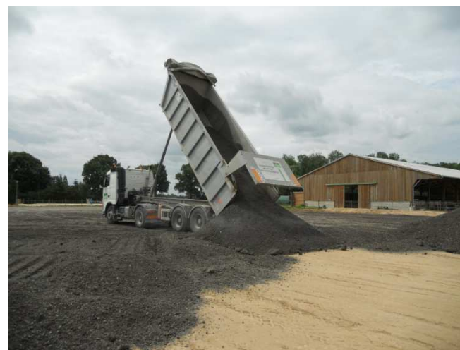
Chantier de Fontenay-Tresigny (77)
