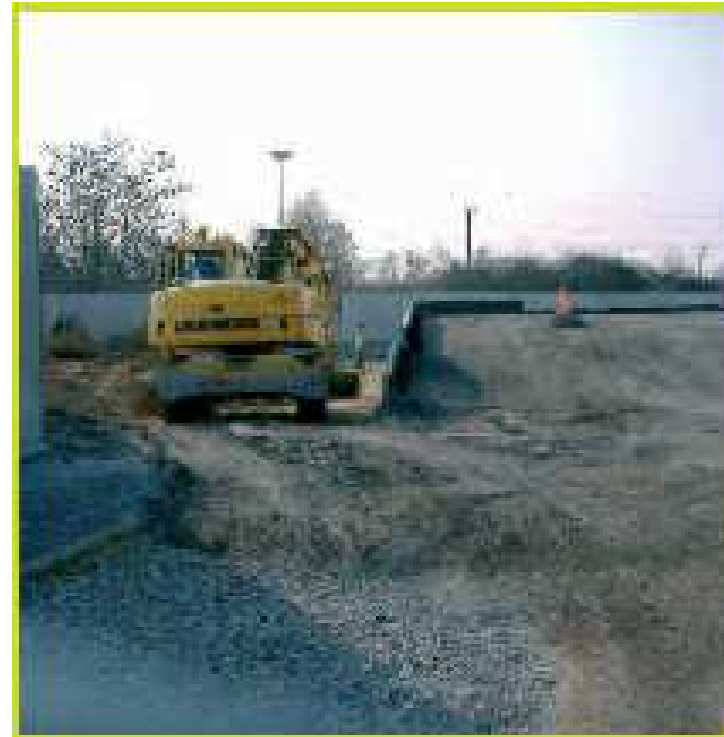
Chantier de La-Queue-en-Brie (94)
