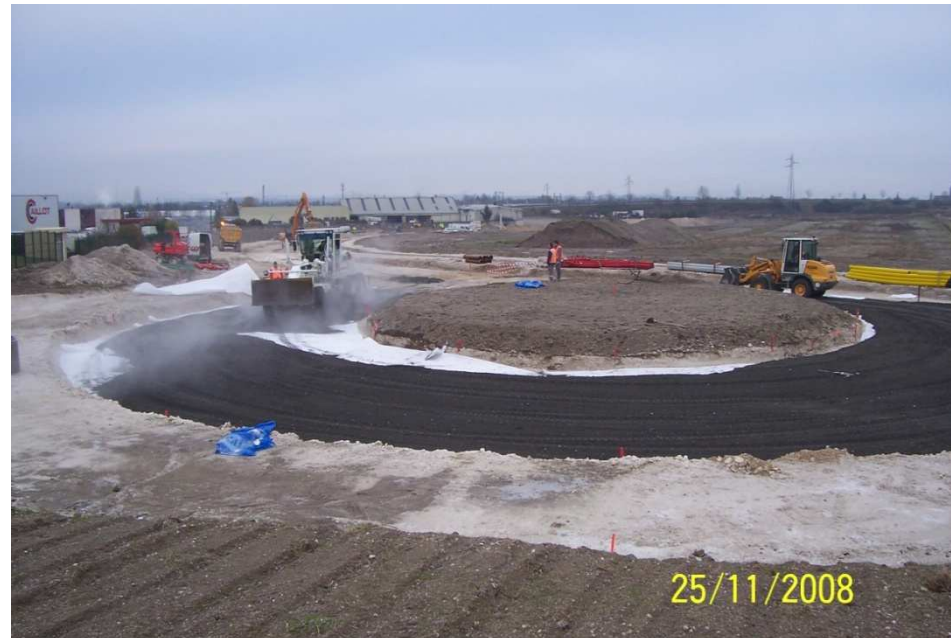
Chantier de Bétheny (51)
