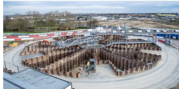
Puit de départ d'un tunnelier Champigny plateau
